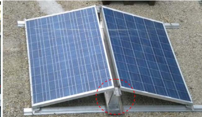
**Bild 20** ballastarmes System Ost-West-Aufständigung
